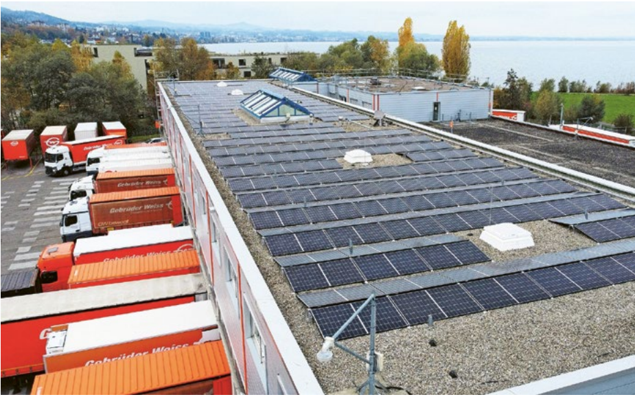
Die neue Photovoltaikanlage von Gebrüder Weiss am Standort Altenrhein. (Quelle: Gebrüder Weiss / Liridon Pallata)
