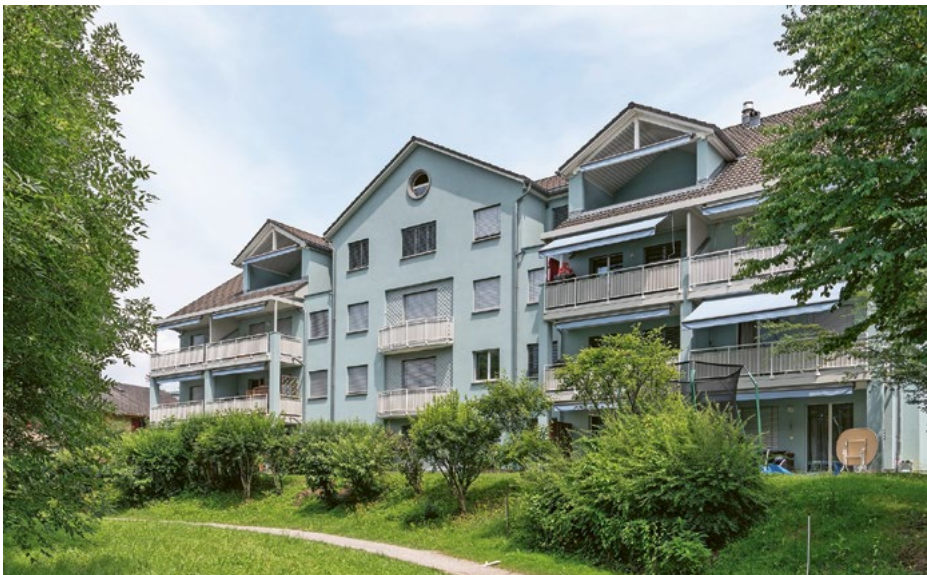
Eine Minergie-Systemerneuerung bietet einfache und individuelle Lösungen.
