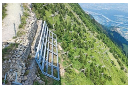
Der Rahmen für die neuen Solarmodule ist bereits installiert, doch die Bewilligung steht noch aus.
