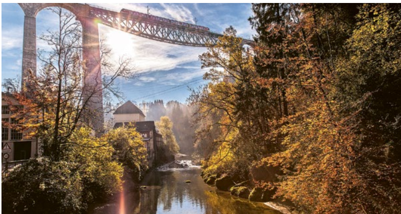
Im St. Galler Kubel betreiben die SAK gemeinsam mit der Osterwalder Gruppe und der SN Erneuerbare Energie AG eine Wasserstoff-Produktionsanlage (Quelle: SOB / Hanspeter Schenk).
